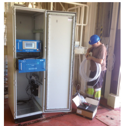
Monitoreo de mercurio en interiores en la planta de tratamiento de Hg en Europa
